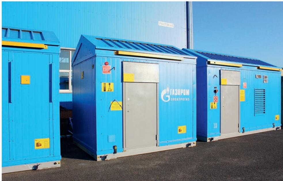
Блочно-комплектные устройства электроснабжения типа БКАЭ-ЭГ-01-40/30-1-УХЛ1, изготовленные филиалом «Афипэлектрогаз» для объекта «Конденсатопровод Уренгой – Сургут (II нитка)». Участок км 107-й – км 288-й
