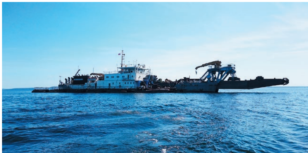
Работа техники ООО «ПГЭС» в условиях большой открытой воды
