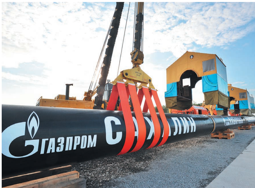
Сварка первого стыка газопровода Сахалин – Хабаровск – Владивосток
