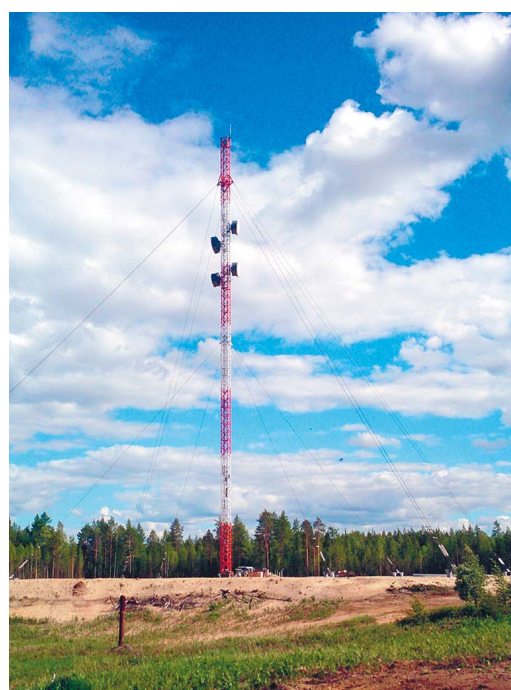
Техническое перевооружение систем оперативной технологической связи ООО «Газпром трансгаз Югорск»
