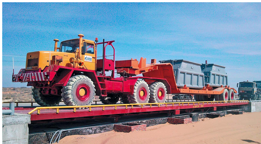
Автовесы, построенные ООО «Газпром центрремонт» для Астраханского газохимического комплекса
