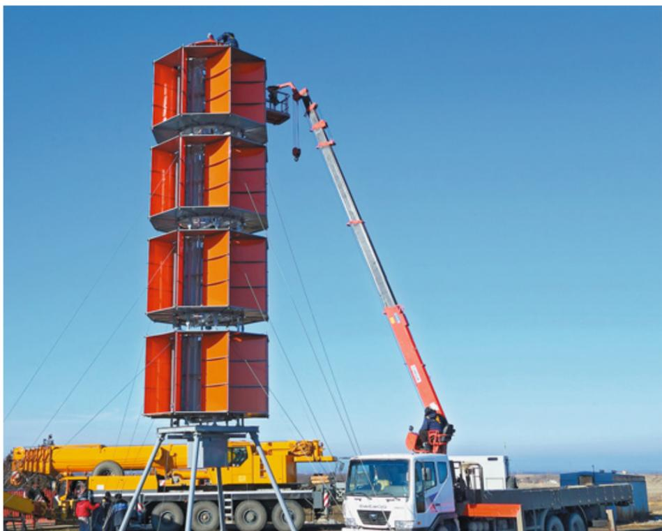
БКЭС-СМ-ВЭУ с использованием ветроэнергетической установки роторного типа
