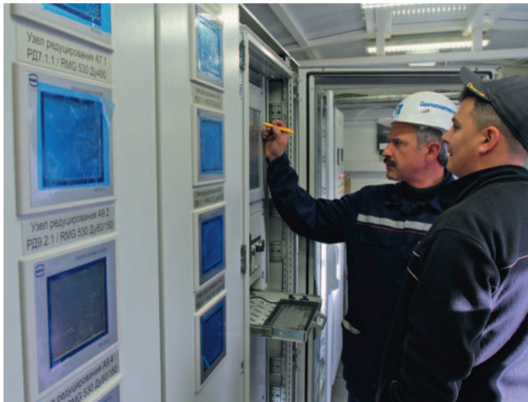
Ведущий инженер-электроник ООО Завод «Саратовгазавтоматика» А.А. Аратов проводит проверку функционирования САУ ГРС «Адлер»
