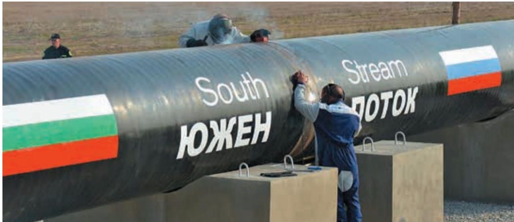
Строительство газопровода «Южный поток» в Болгарии
