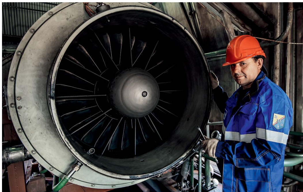
Демонтаж газотурбинного двигателя
