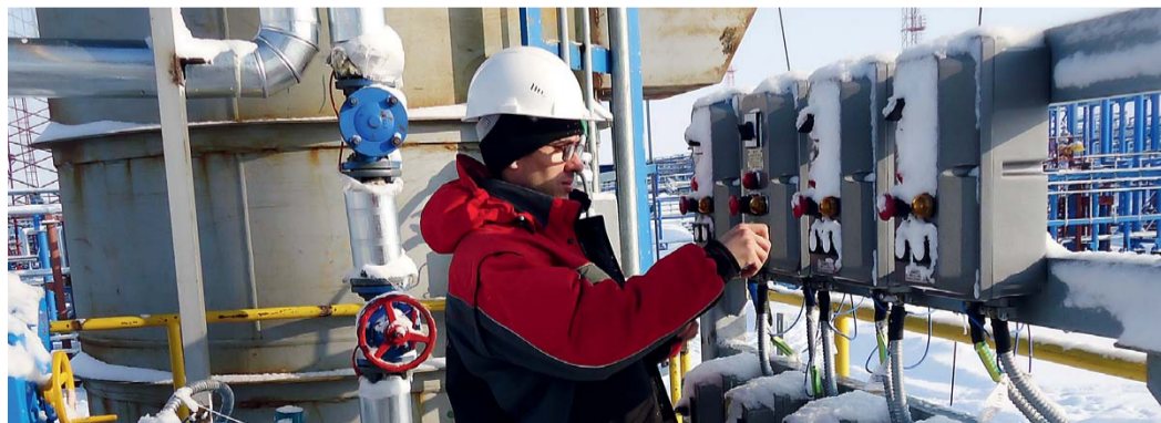
Сотрудник АО «Газпром оргэнергогаз» проводит наладку оборудования
