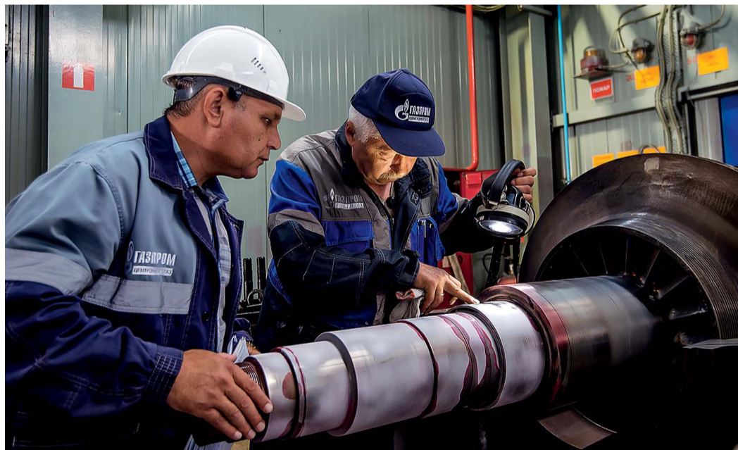
Дефектоскопия ротора центробежного нагнетателя
