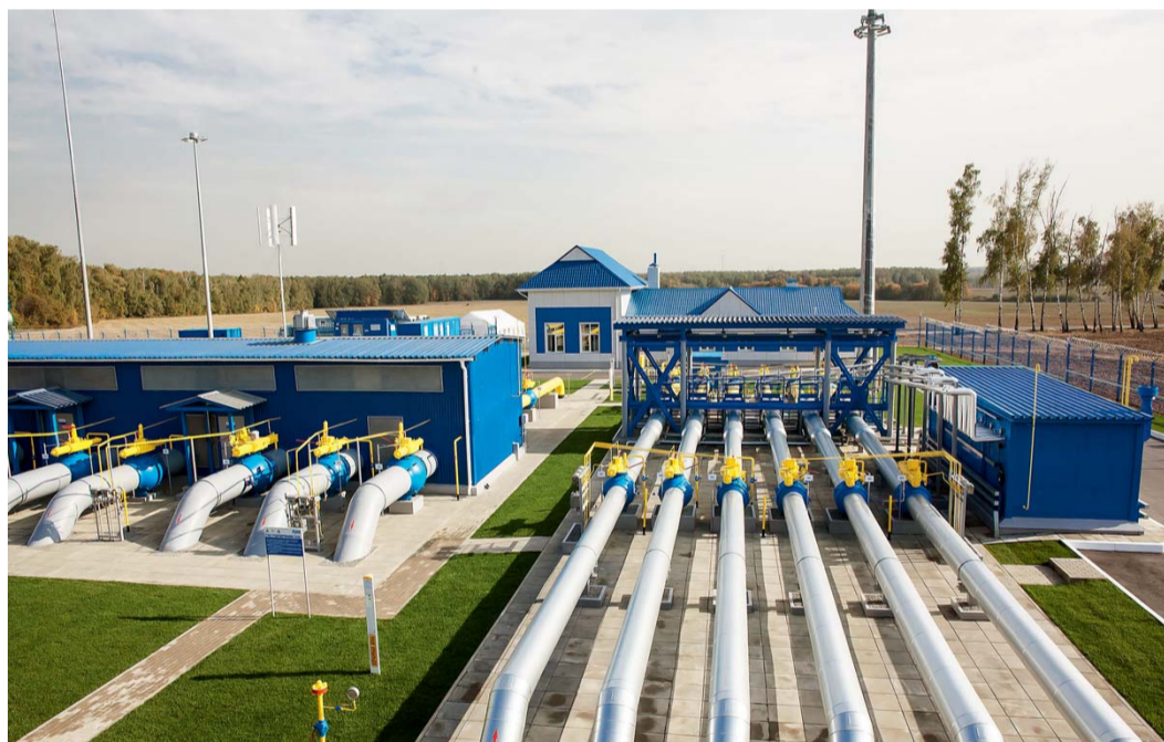
Контрольно-распределительный пункт 16 после реконструкции
