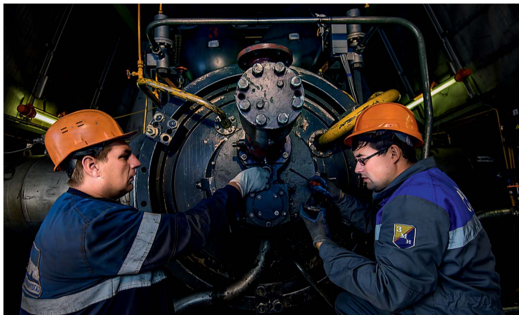
Слесари-ремонтники АО «Газпром центрэнергогаз» за работой
