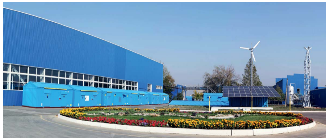
Производственная площадка филиала «Афизэлектрогаз» АО «Газпром электрогаз»
